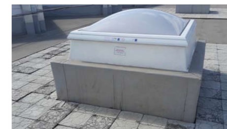
Рассечки при помощи тротуарной плитки
