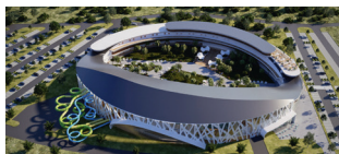
Крытый Аквапарк, Белгородская область
