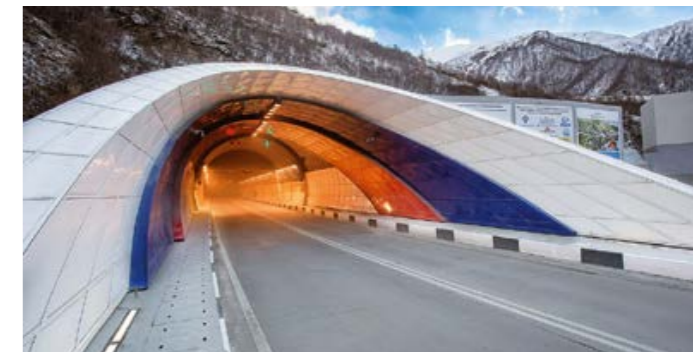
Рокский тоннель между Северной и Южной Осетией на 93-м километре Транскавказской магистрали
