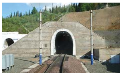
Джебский тоннель, Красноярский край
