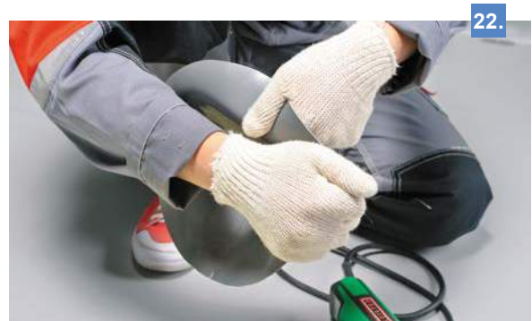
Растягивайте прогретый участок до получения «юбки», располагая руки как показано на фото. Последовательно прогрейте и растяните заготовку по всей окружности.
