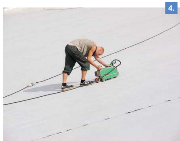
Рис. 2.9.8 После приклейки к основанию - мембрана сваривается обычным образом
