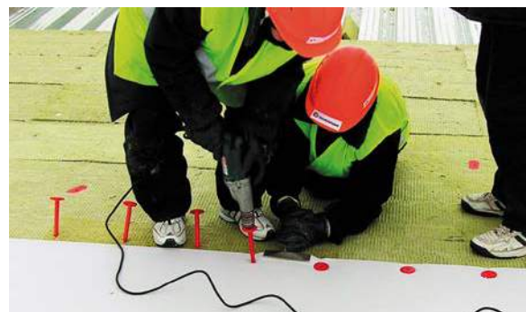
Рис. 5.4.5 Натяжение мембраны
