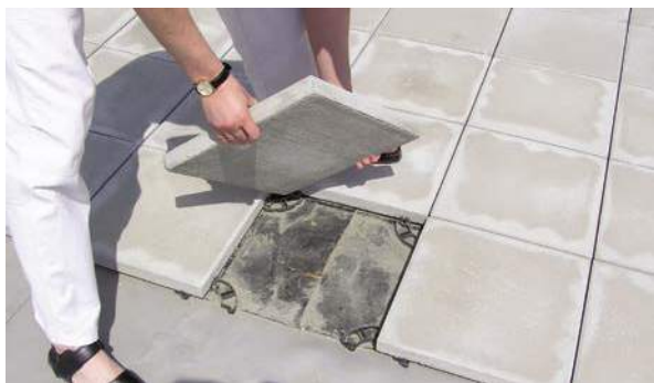
Рис. 2.7.3 Применение в качестве балласта тротуарной плитки
