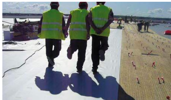
Рис. 5.4.3 Натягивание рулона
