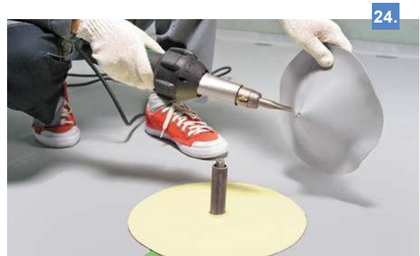
Прогрейте мембрану вокруг отверстия ручным феном.
