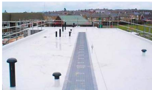
Рис. 4.2.5 Пешеходная дорожка ТехноНИКОЛЬ на кровле
