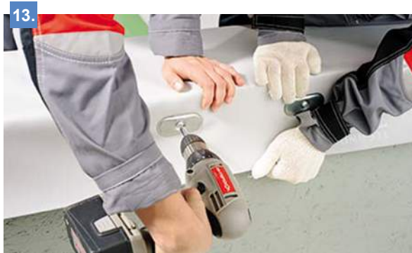
13. Прикрепите мембрану механически с наружной стороны парапета.
