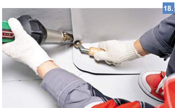
18. Приварите все нахлесты. На горизонтали предварительно снимите фаску с края нижней мембраны.
