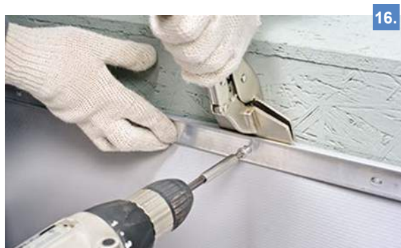
16. Для парапетов высотой более 350 мм используйте завершение с краевой рейкой. Крепите краевую рейку начиная от середины, чтобы можно было равномерно натянуть мембрану по всей длине парапета. Для натяжения мембраны используйте «зажим кровельщика».
