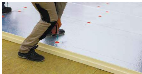
Рис. 2.4.1 Монтаж системы ТН-КРОВЛЯ Смарт PIR
