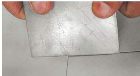
Рис. 5.2.15 Фиксация T-образного шва металлической пластиной
