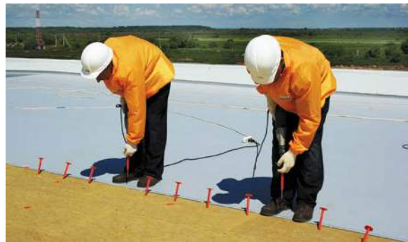
Рис. 5.4.4 Механическое крепление мембраны
