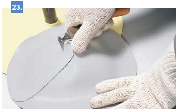
Сделайте надрез кровельным ножом на вершине конуса.
