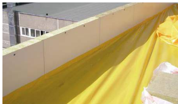
Рис. 3.1.5 Укладка пароизоляционной пленки ТехноНИКОЛЬ
