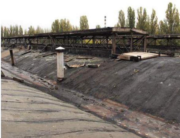
Рис. 2.10.2 Старая битумная кровля
