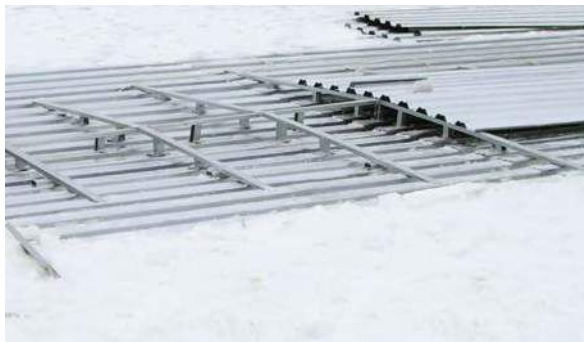
Рис. 3.3.4 Вариант устройства разуклонок
