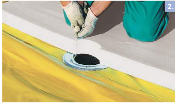
Рис. 3.6.10 Последовательность установки двухуровневой воронки
