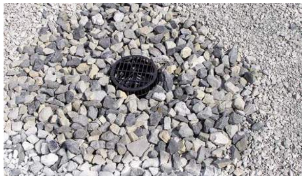
Рис. 2.7.5 Увеличение фракции балласта вокруг воронки
