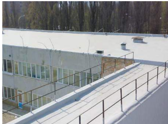
Рис. 2.9.2 Вид кровли после реконструкции полимерными мембранами с доутеплением
