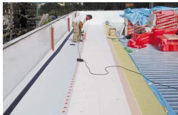
Рис.3.5.17. Монтаж метровых рулонов ТехноНИКОЛЬ
