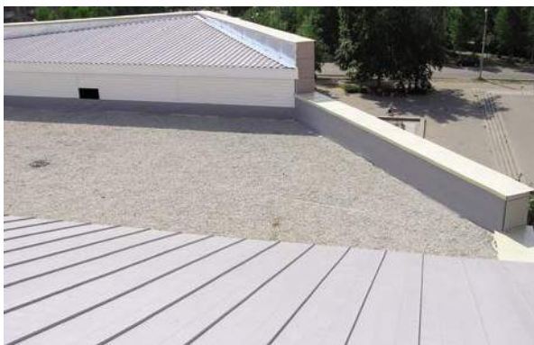
Рис. 2.7.1 Вид балластной кровли
