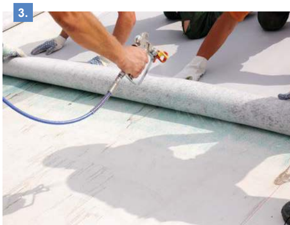
Рис. 2.9.7 Процесс нанесения клея на основание и на мембрану
