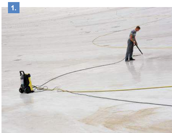
Рис. 2.9.5 - Рис. 2.9.6 Подготовьте старое основание: очистите, обеспыльте, просушите
