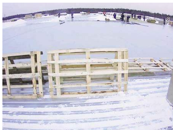
Рис. 3.1.9 Защита края кровельного пирога от хождения
