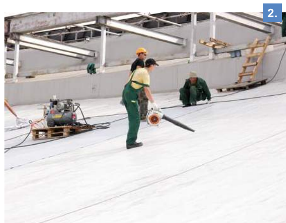
Рис. 2.9.5 - Рис. 2.9.6 Подготовьте старое основание: очистите, обеспыльте, просушите
