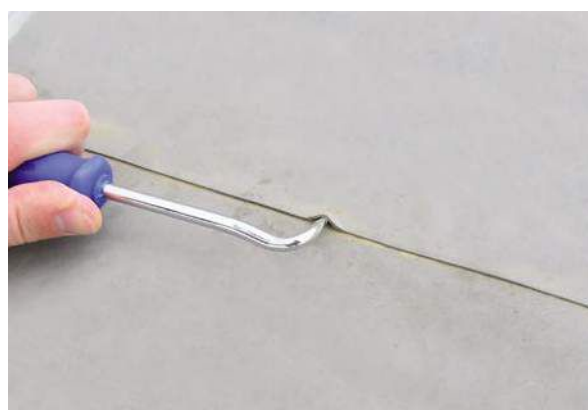
Рис. 5.2.9 Контроль при помощи специальной чертилки
