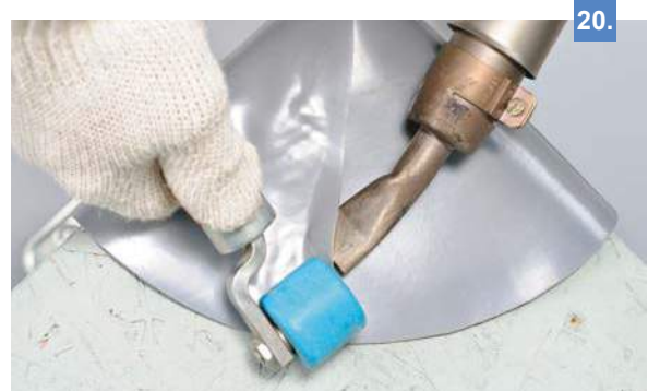
Выверните деталь наизнанку и проварите шов с внутренней стороны. Проверьте качество сварного шва пробником.
