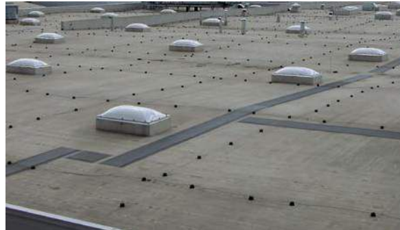
Рис. 3.6.4 Вид кровли с применением пешеходной дорожки ТехноНИКОЛЬ
