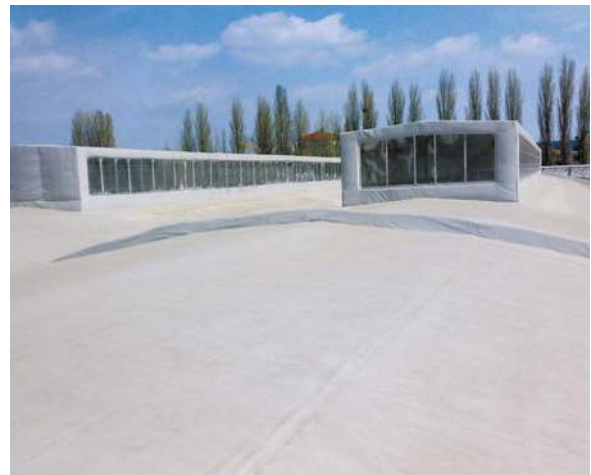
Рис. 2.10.3 Вид кровли после реконструкции полимерными мембранами с доутеплением
