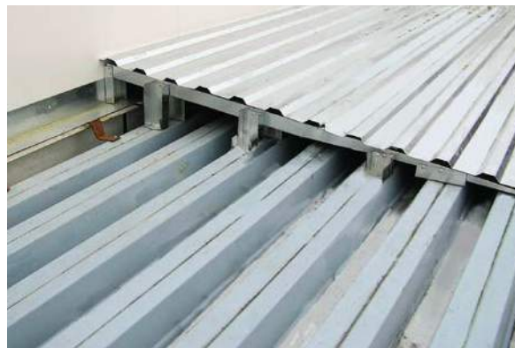
Рис. 3.3.7 Устройство контруклона с помощью подконструкции из профиля с укладкой поверх профлиста
