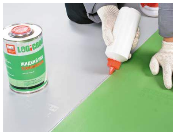
Рис. 3.4.2 Обработка стыка жидким ПВХ
