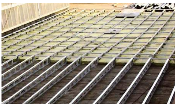
Рис. 3.3.3 Вариант устройства разуклонок
