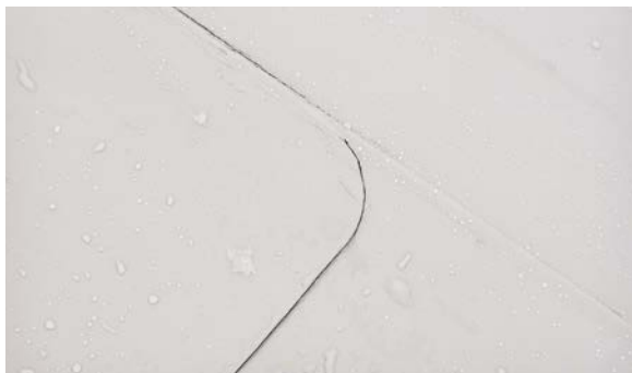
Рис. 5.4.1 Скругление углов мембраны
