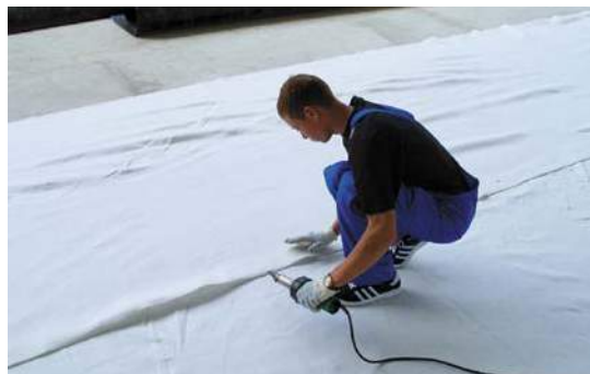
Рис. 3.3.1 Сварка полотнищ геотекстиля между собой
