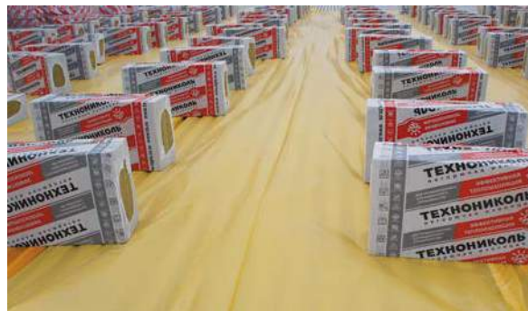
Рис. 3.1.4 Укладка пароизоляционной пленки ТехноНИКОЛЬ
